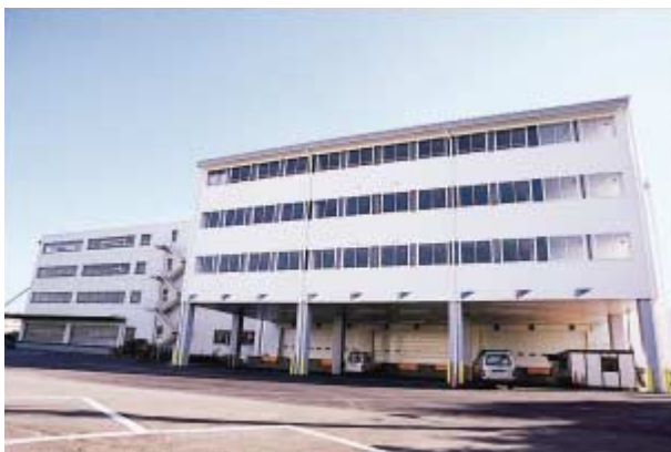
横浜営業所新倉庫棟全景
