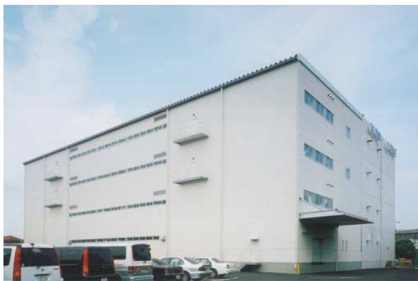
大阪営業所増築倉庫棟全景
